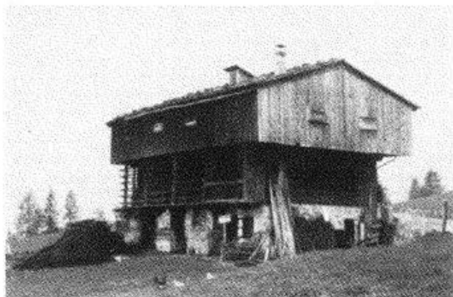
Holzhaus mit Steinfundament in Sauris
