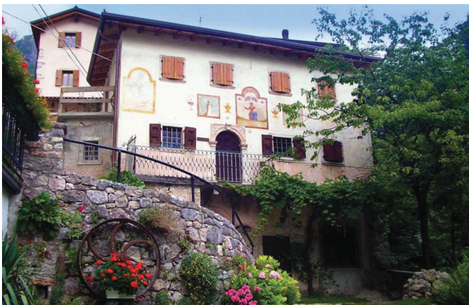
Gebäude der früheren Mühle in Giazza/Ljetzan
